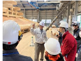
正殿工事現場視察
