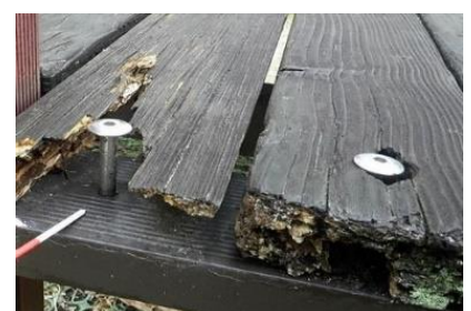
遊具点検の様子
